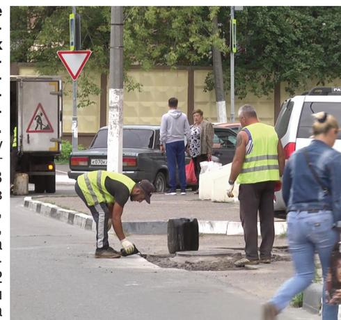
Тимирязева, 19. В прошлом году здесь проводился ремонт теплотрассы. После его завершения на один из участков положили плитку. Но срок ее эксплуатации оказался невелик. Дорожное полотно провалилось, вследствие чего образовалась яма. Теперь проблема устранена. Прежде всего ремонту подлежат те дефекты асфальтного покрытия во дворах, по которым поступают обращения от жителей в Центр управления регионом или на портал «Добродел».
